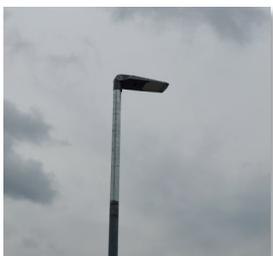
*So sehen die neuen energie-sparenden LED-Lampenköpfe aus. Sie dienen nur mehr der gezielten Gehwegbeleuchtung und sind keine Rundum-Beleuchtung mehr.*
